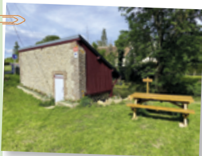
Rénovation du lavoir
